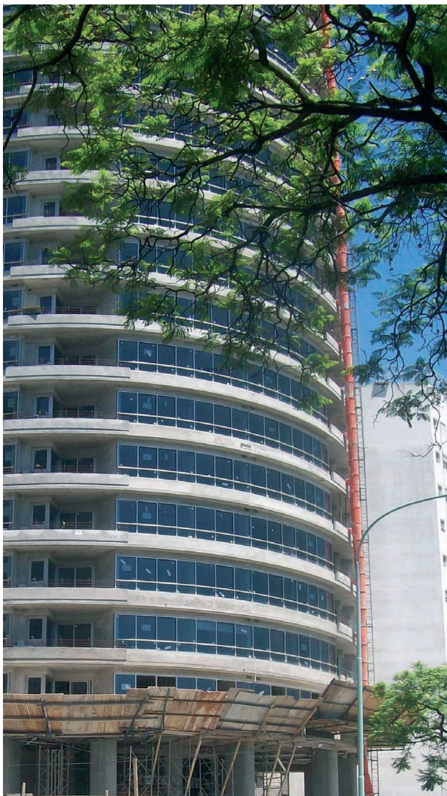
Edificio en torre en obra.
