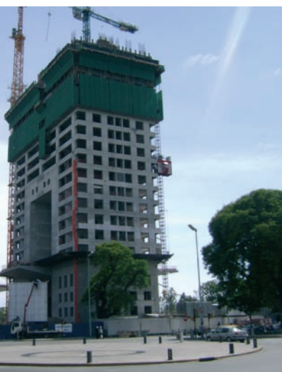
Escena común en los últimos años, de un edificio en obra de gran altura.
