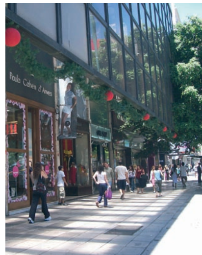
Fachada de un edificio de oficinas del centro porteño.
